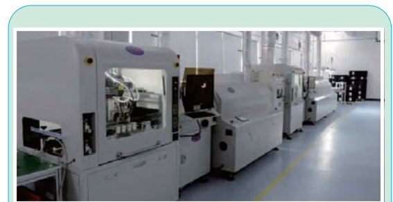
注：三防漆自动喷涂线
